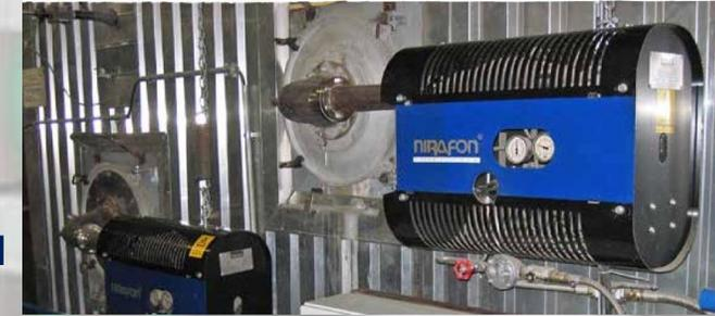
**Ventajas del limpiador acústico en comparación con el método de limpieza más común; soplado de hollín**
