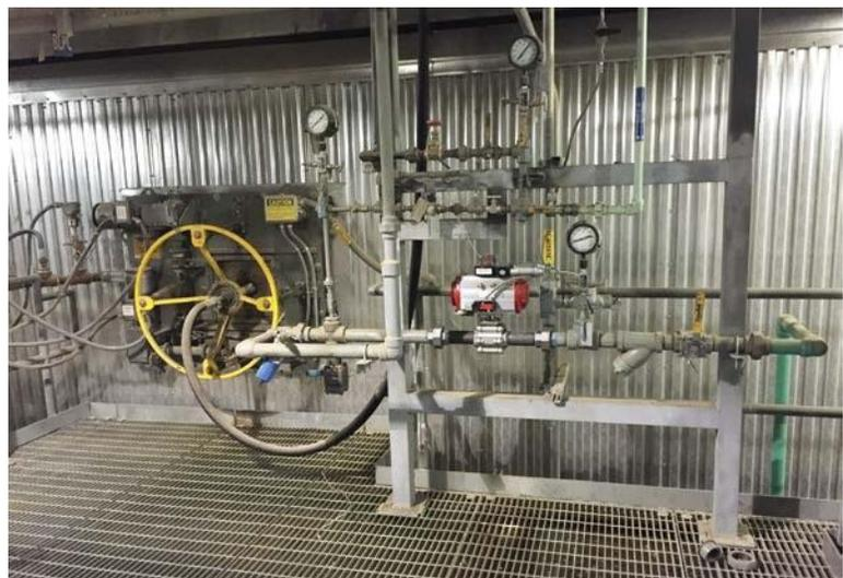
*El sistema de limpieza de agua Diamond Power HydroJet con válvulas asociadas y conjunto de plomería presenta un diseño compacto para facilitar el acceso.*
